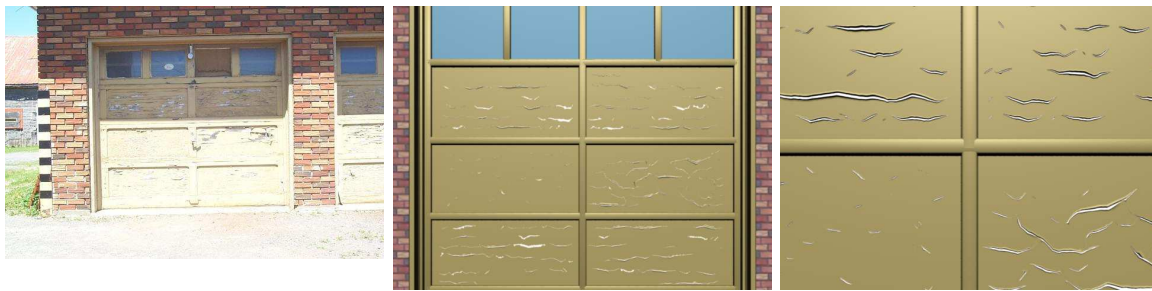
Figure 4. Gauche : image réelle, centre : image synthétique avec écaillage simulée, droite :, zoom sur la simulation.
